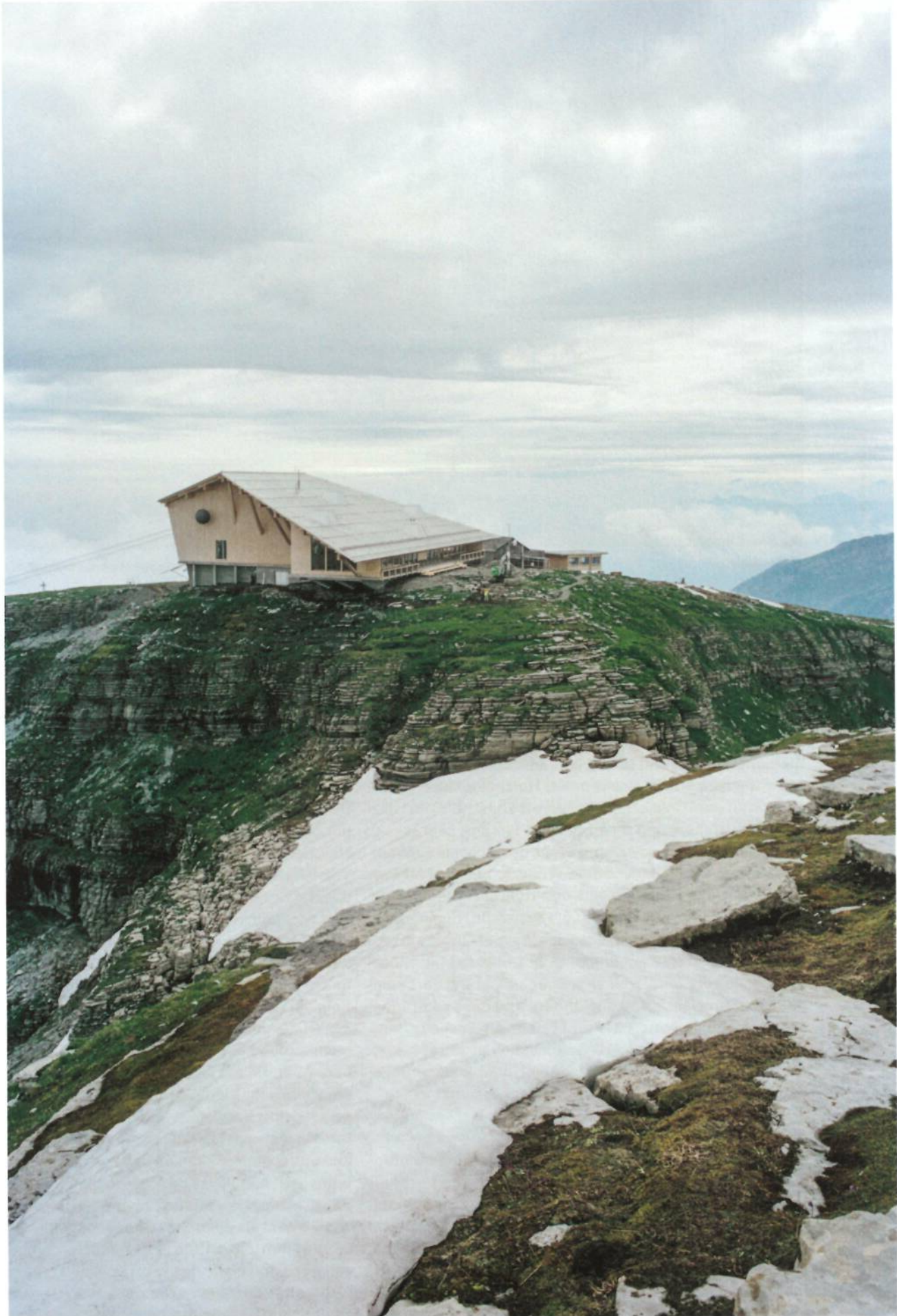
Mit einem grossen Dach fassen Herzog & de Meuron Architekten die bestehende Bergstation und das neue Restaurant auf dem Chäserrugg zusammen.
